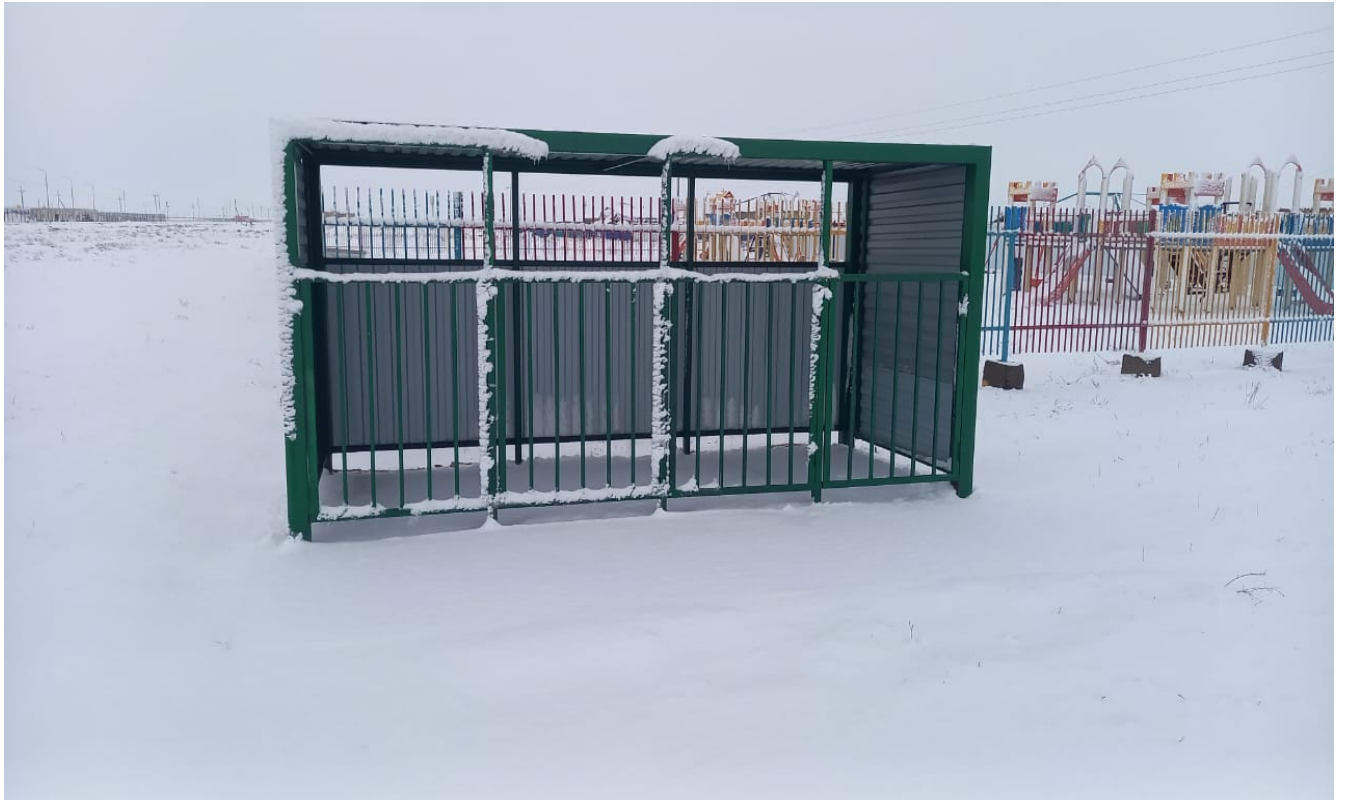
6) Контейнерная площадка в с.Мукур
